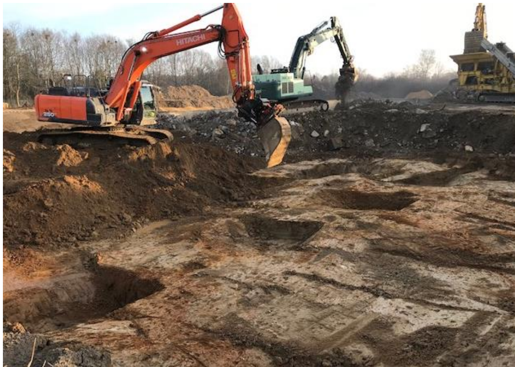
Figur 2: Udgravning ifm. nedrivning.
