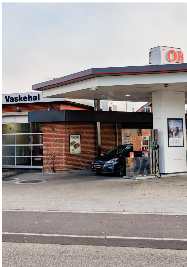
Skiltning på facader og overdækningens bærende konstruktioner
