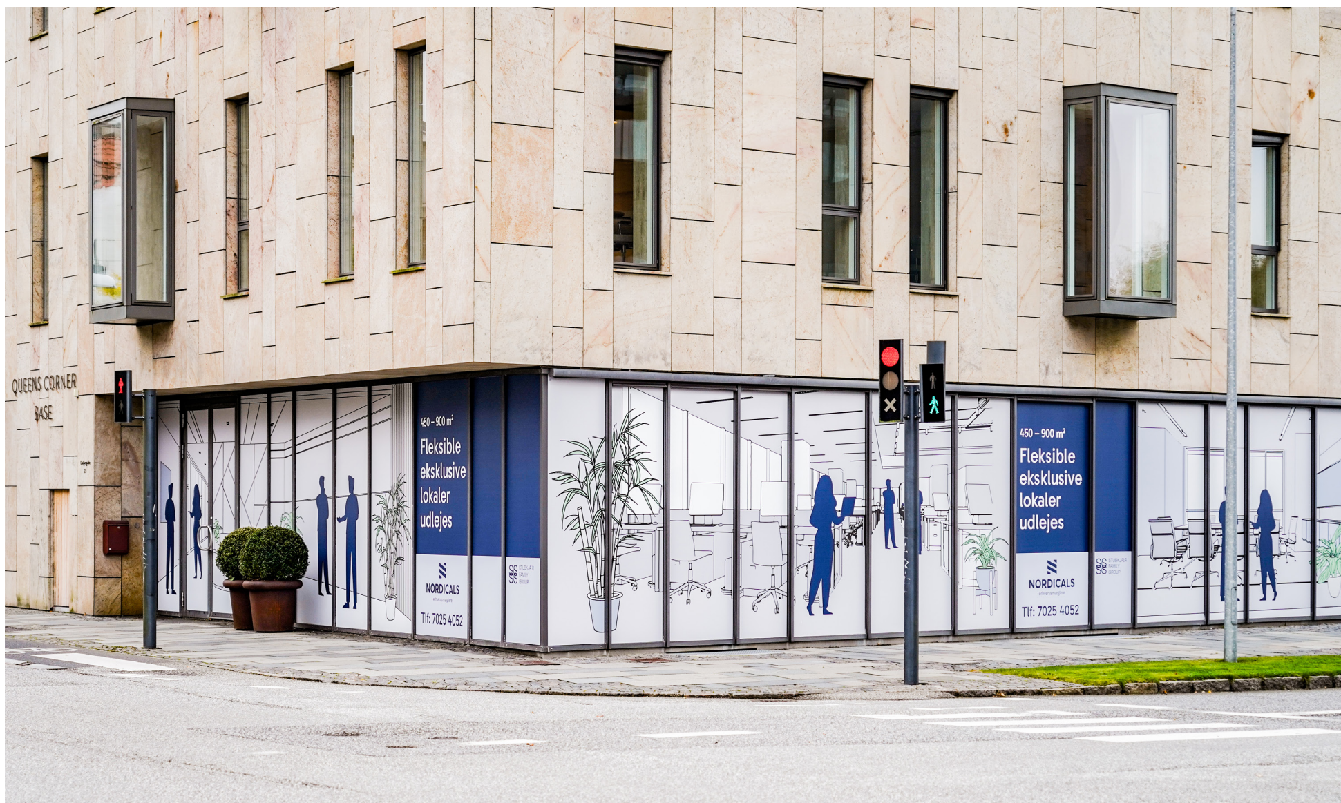
Midlertidig blænding af vinduespartier i forbindelse med tomgang
